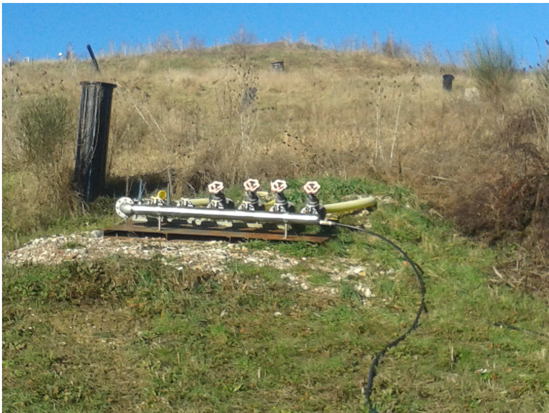
5. Collettore pozzi biogas attuale (non sostituito né spostato nel progetto)
