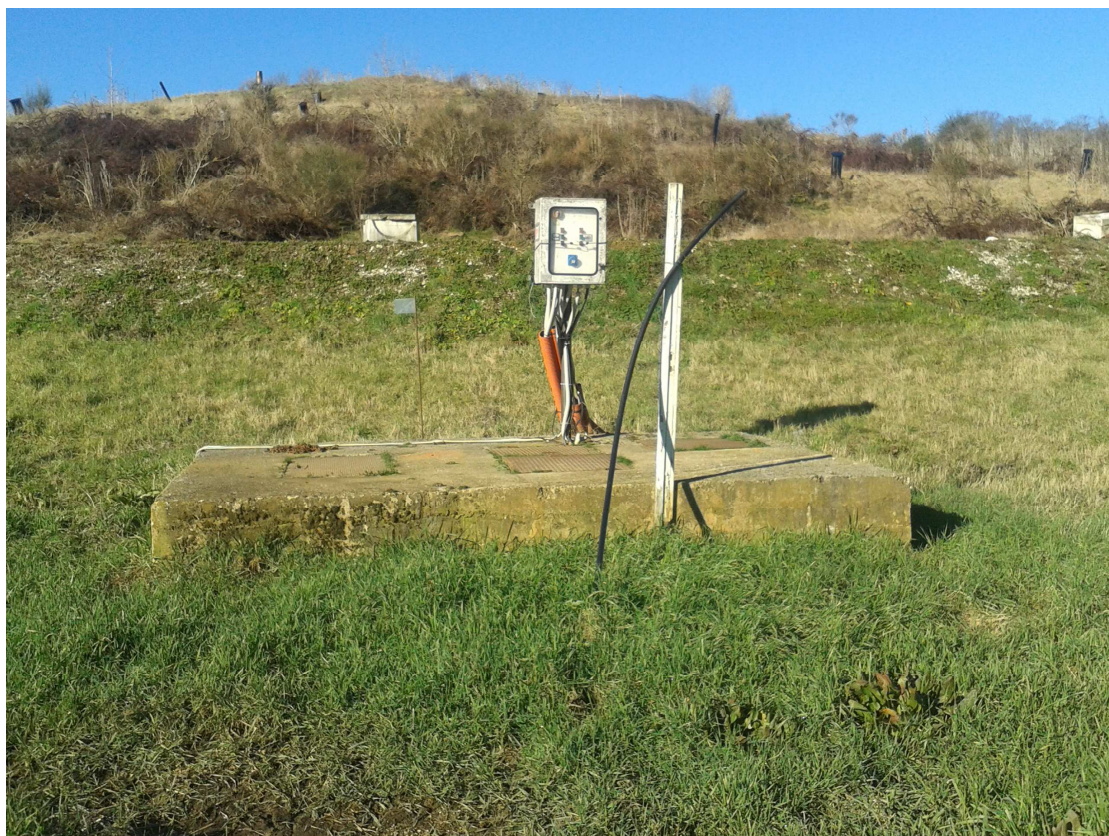
9. pozzo sollevamento percolato (esistente) e zona di alloggiamento nuova centrale
