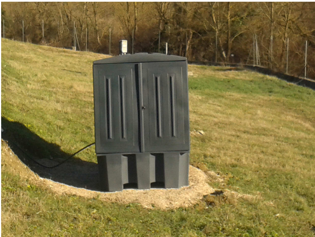
6. Raccogliore condensa con vasca per sversamenti accidentali (non sostituito nel progetto – spostato sulla platea di progetto vicino alla torcia)
