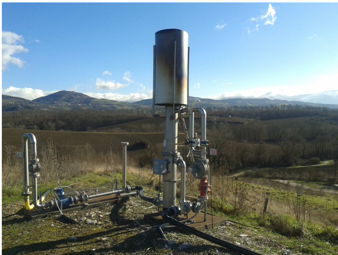
1. Torcia di termodistruzione esistente
